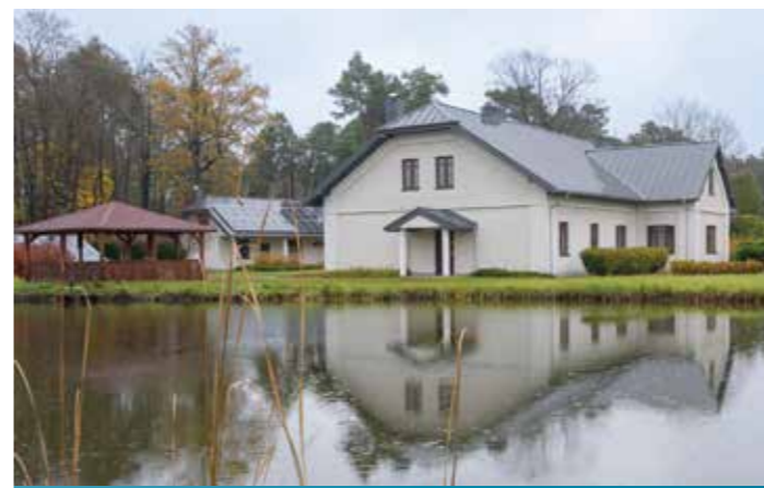
DZIĘKI DOFINANSOWANIU Z UNII EUROPEJSKIEJ DAWNY BUDYNEK STACJI DOŚWIADCZALNEJ RYBACKIEJ UDAŁO SIĘ GRUNTOWNIE WYREMONTOWAĆ
