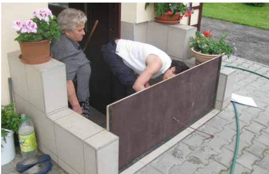
POMIESZCZENIA ZLOKALIZOWANE PONIŻEJ POZIOMU GRUNTU NARAŻONE SĄ NAJBARDZIEJ - MURKI I ZASUWY TO NAJCZĘŚCIEJ SPOTYKANE ZABEZPIECZENIA PRZECIWPOWODZIOWE | FOT. ARCHIWUM R. KONIECZNEGO
