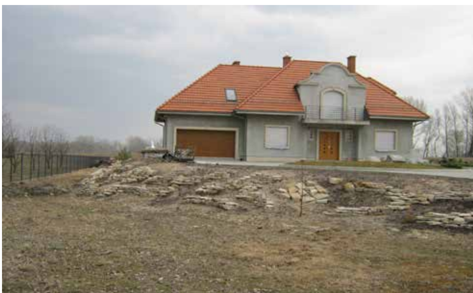
CI, KTÓRZY BUDUJĄ DOM NA ZAGROŻONYM POWODZIĄ GRUNCIE, DOBRZE WIEDZĄ, ŻE BUDYNEK MUSI BYĆ USYTUOWANY NA ODPOWIEDNIO WYSOKIM NASYPIE | FOT. ARCHIWUM R. KONIECZNEGO
