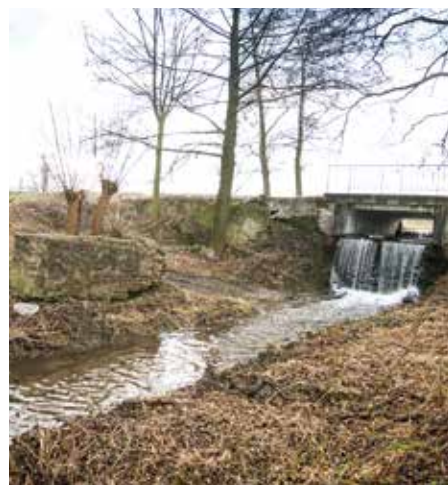
Po dawnym słabkowickim młynie wodnym pozostały jedynie fragmenty muru oporowego.
